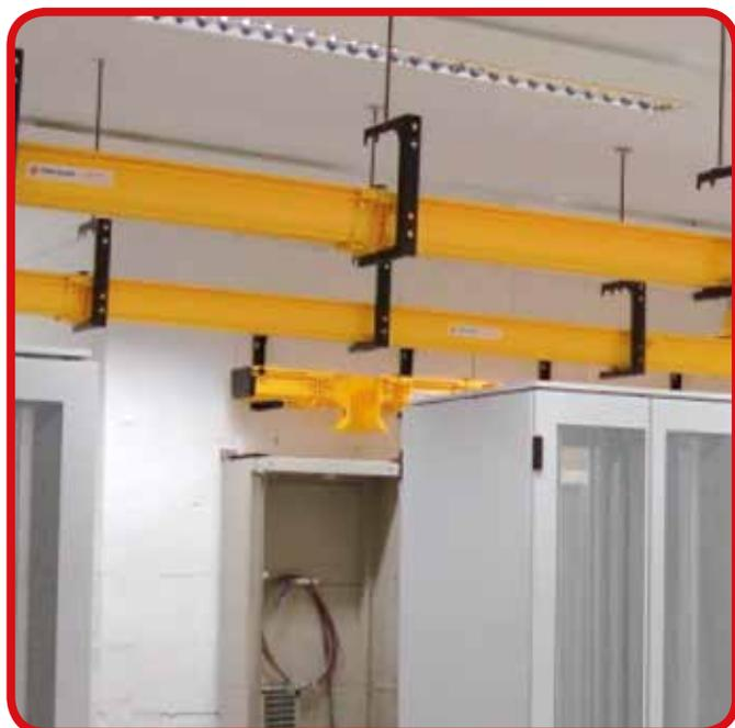
Aktive Führung von LWL-Patch- und Außenkabel. Absolute Kontrolle der Biegeradien. Einfache Installation und modular zusammensetzbar.
